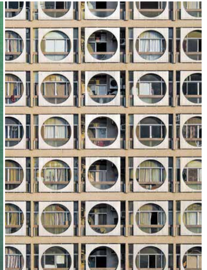
عمارة عبيد المزروعى، أبوظبي Obeid AlMazrouei building, Abu Dhabi
